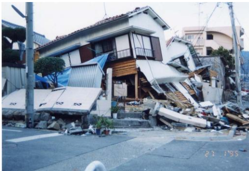
写真 2-1 著しい構造的被害
