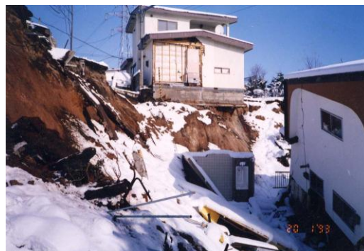
写真 2-4 斜面の崩壊(Cランク)
