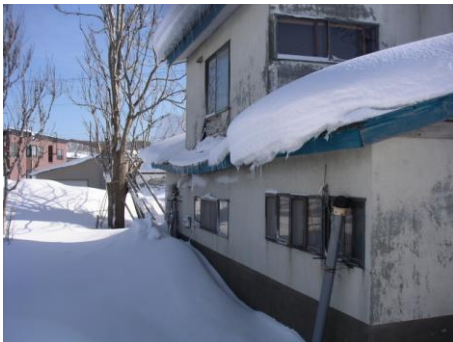
写真1 敷地内の積雪や屋根雪の状況
