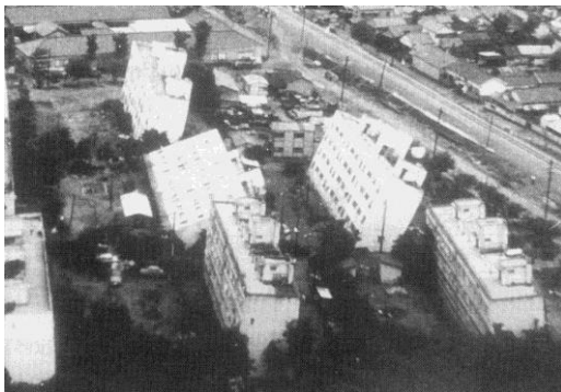
写真 4-13 全体沈下と全体傾斜
