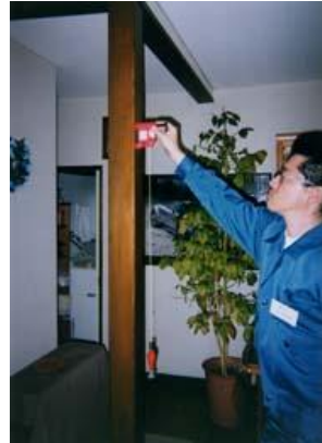
写真2-9 下げ振りによる傾斜の測定
