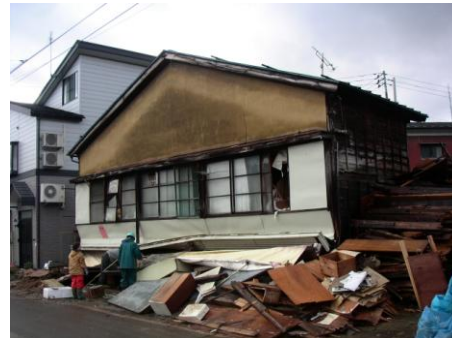
写真 2-2 低層階の崩壊
